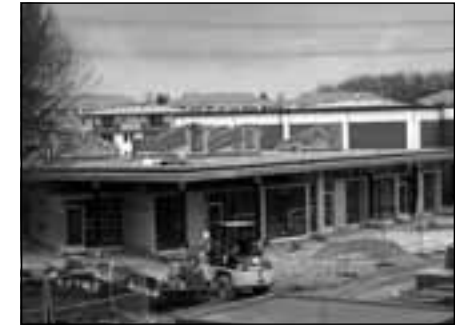
Wand an Wand: Die noch im Bau befindliche neue Kita und das TSG Trendsportcenter
